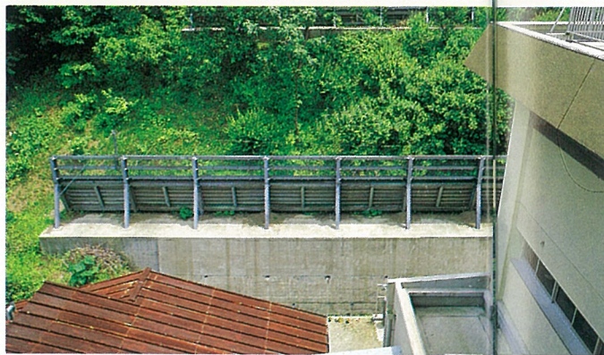
坂本 昭和52年度 東秩父村坂本 落石防止さく工
