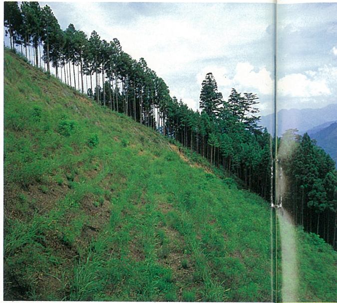
滝の沢 昭和52年度 大滝村大滝 法切工 伏工 筋工 植栽工
