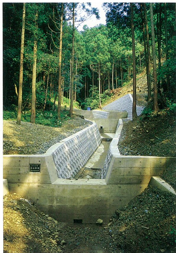
帰驗棒 昭和55年度 都幾川村西平 コンクリート床固工 コンクリートブロック護岸工
