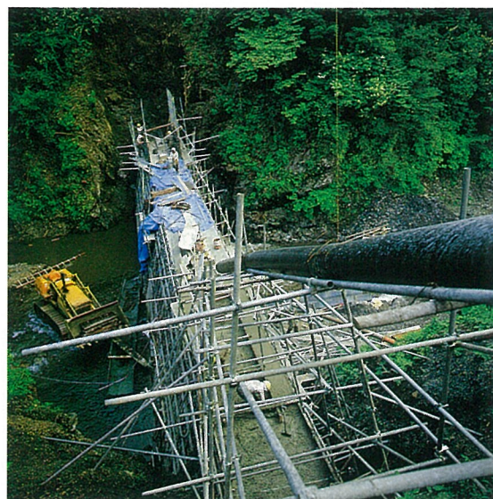
広河原 昭和56年度 秩父市浦山 コンクリート谷止工
