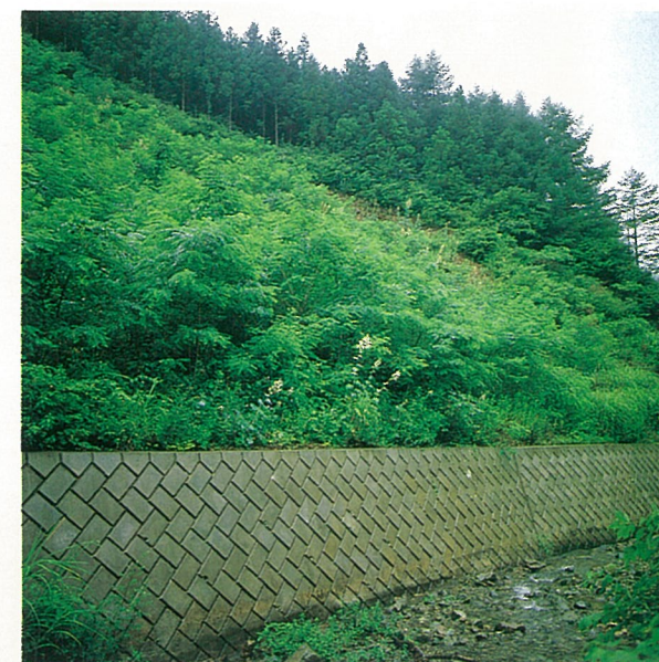
曾沢 昭和53年度 横瀬村横瀬 コンクリートブロック護岸工 山腹工
