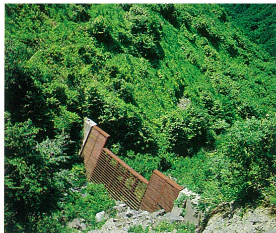
大洞 昭和50年度 大滝村大滝 鋼製谷止工
