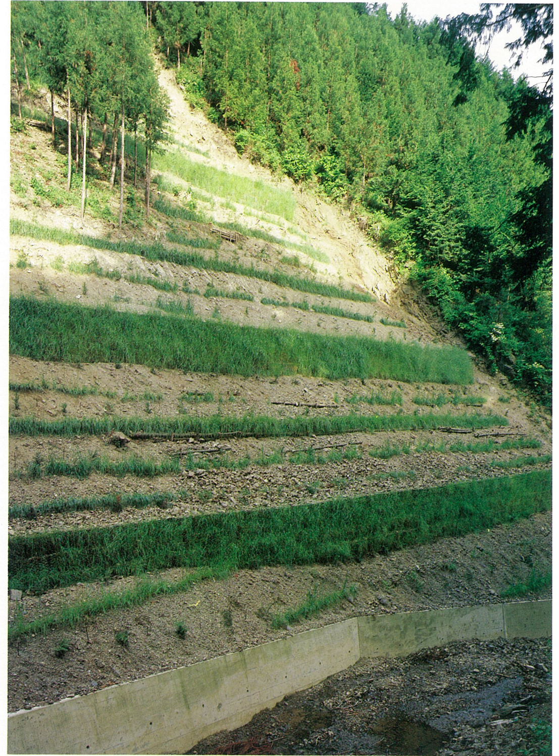
高畑 昭和55年度 飯能市高山 簡易鋼製土留工 筋工
