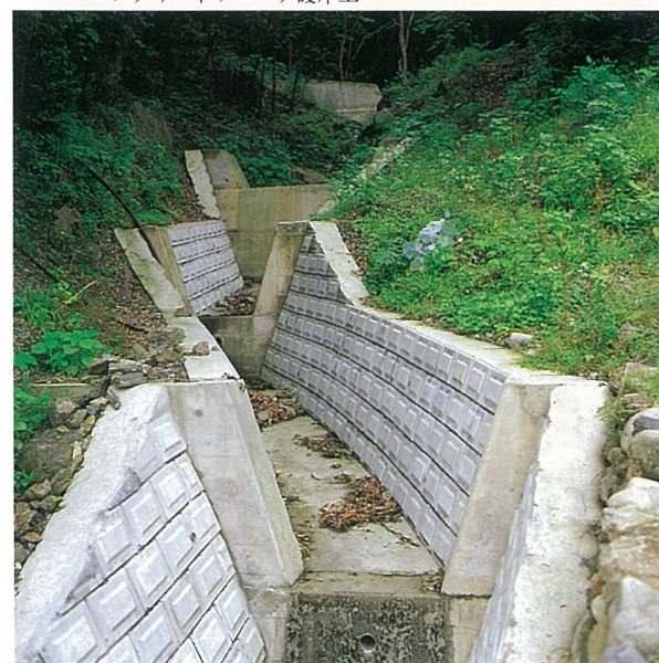
宮沢 昭和54年度 長瀬町野上下郷 コンクリートブロック水路工
