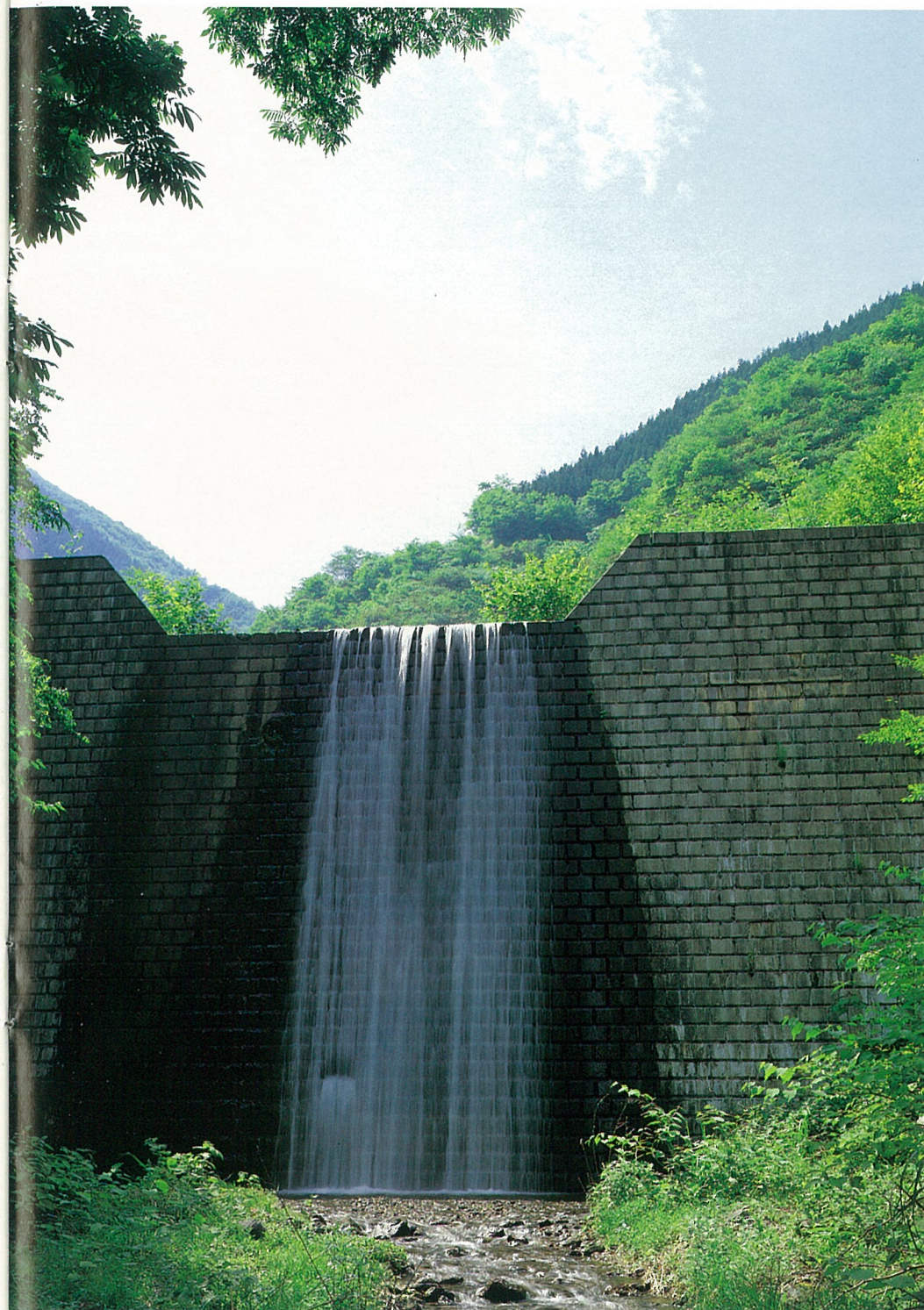
逆川 昭和42年度 名栗村下名栗 モルタル注入谷止工
