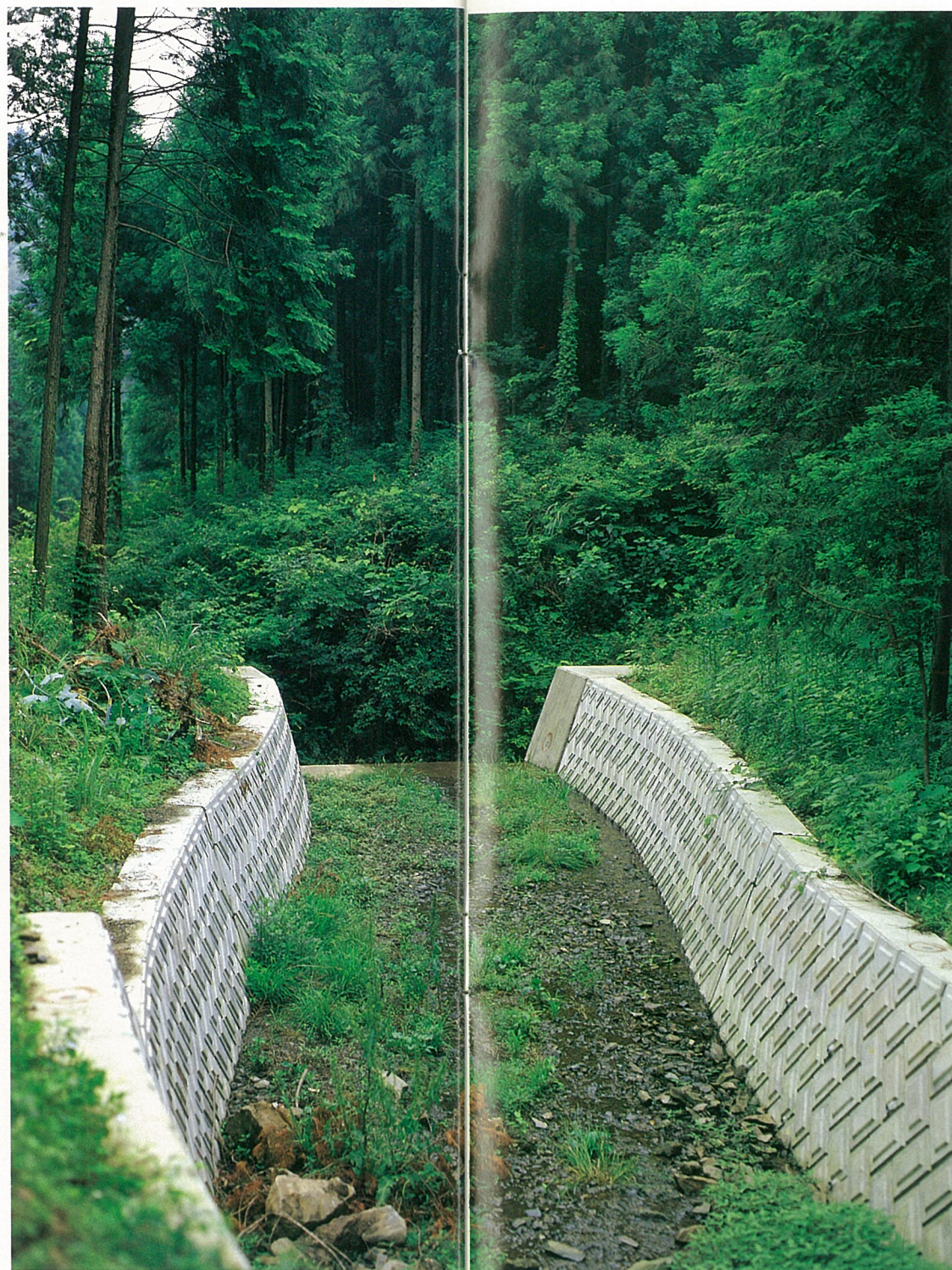
大槻 昭和54年度 美里村白石 コンクリートブロック護岸工
