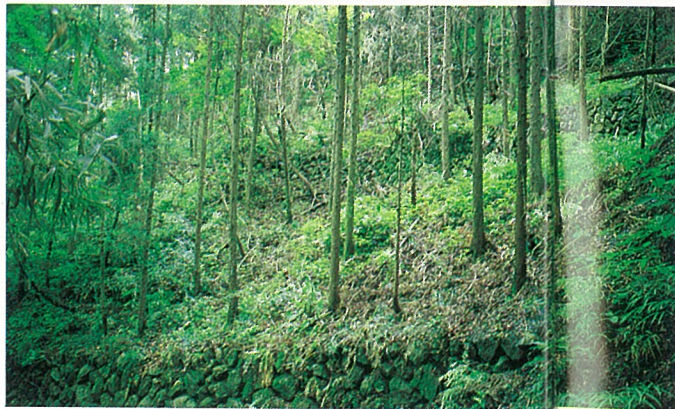
幹沢 昭和24年度 神泉村下阿久原 練積土留工
