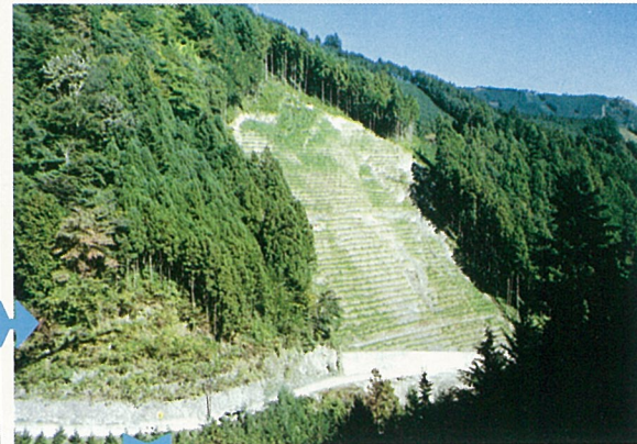
昭和43年被災 昭和44年完成
