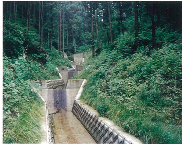
土砂流出防備保安林
