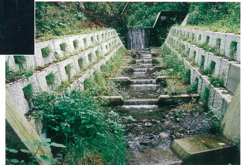
ホタルの生息環境の保全に配慮した流路工(吉田町)
