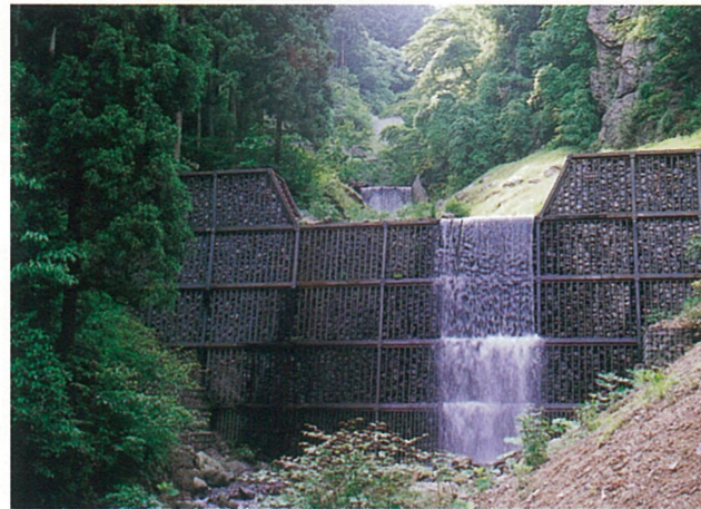
水源地域の透水ダム工
