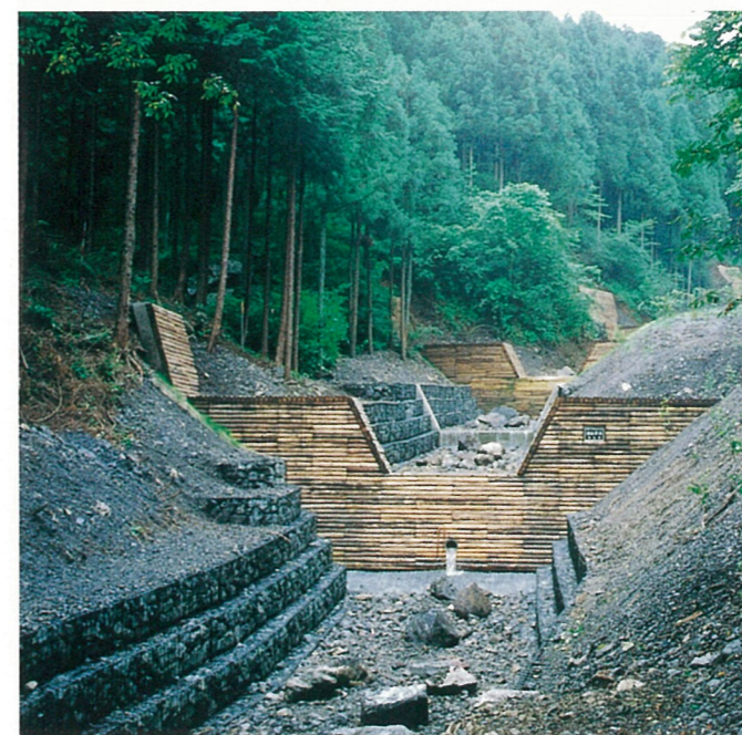
間伐材を利用した治山ダム (横瀬町)
