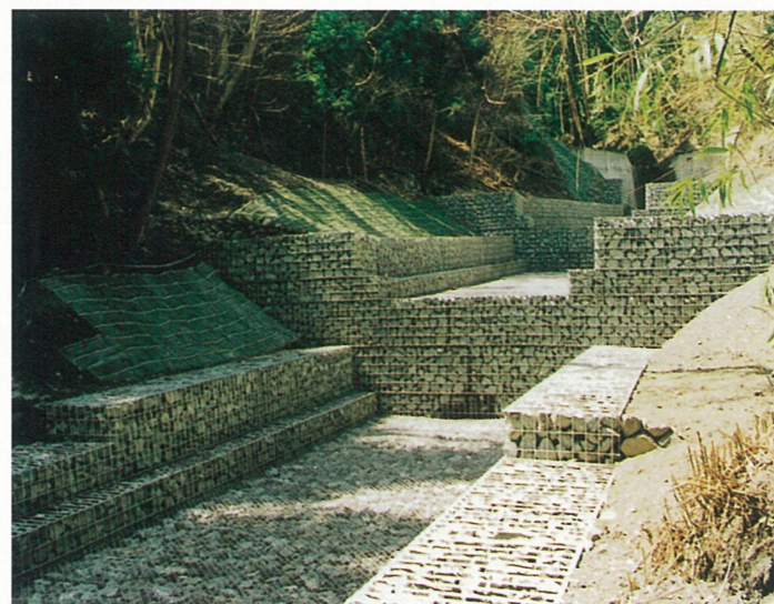
床固工と護岸工を組合せた流路工(吉田町)
