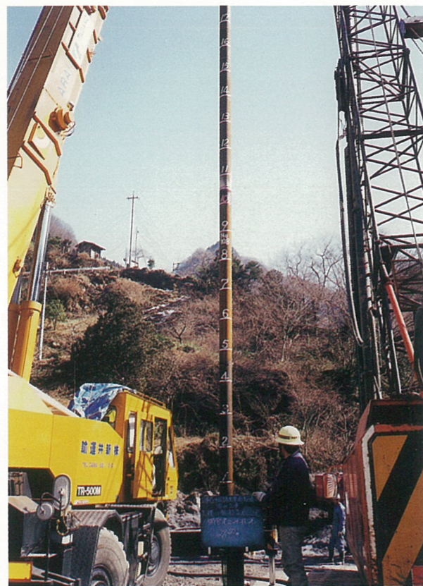
杭打工 (秩父市)
