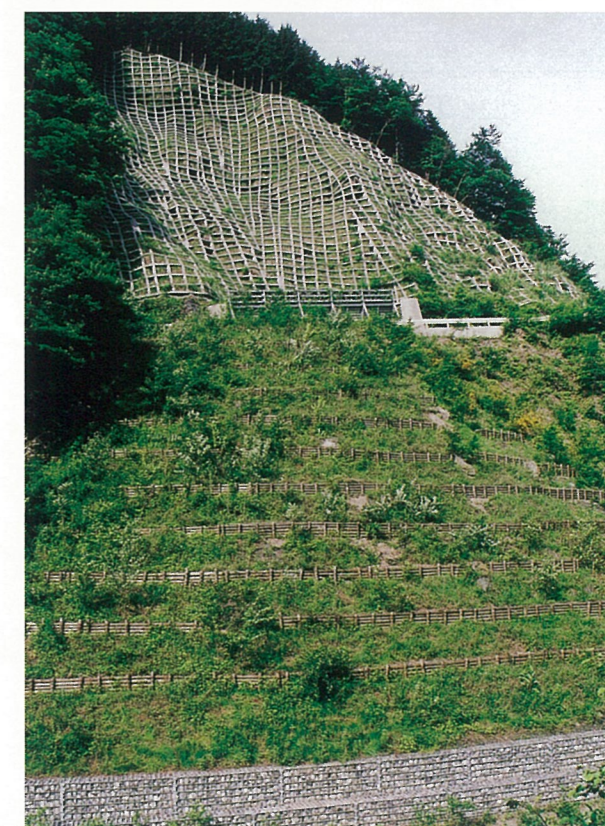
法枠工と土留工、柵工、植栽工等の組合せの例(名栗村)
