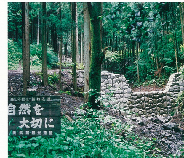
化粧型枠を利用した治山ダム (飯能市)
