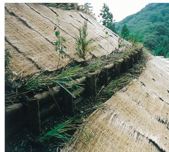
筋工と植栽工・伏工の組合せの例(児玉町)
