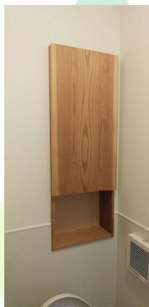
【 収納棚（巾ハギ材）・ガラリ枠 】 S 様邸（設計・施工：有限会社佐藤工務店）
