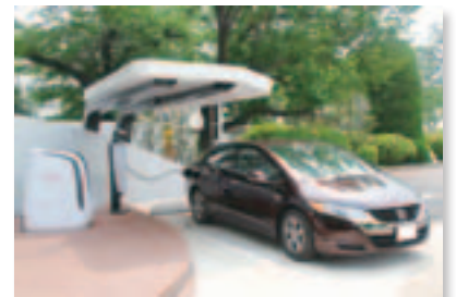
太陽光発電を活用して水素を製造する「次世代ソーラー水素ステーション」
