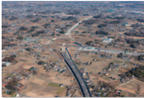
整備が進む圏央道桶川北本インターチェンジ(桶川市)
