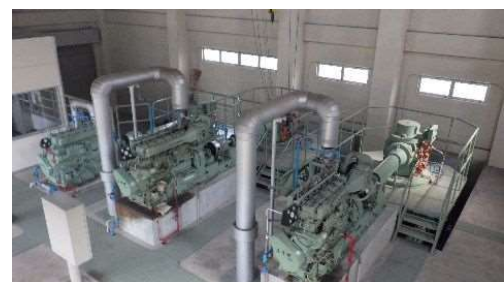
補修整備された排水ポンプ （吉見町 南吉見排水機場地区）
