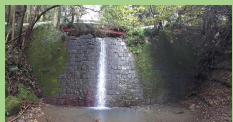
大正5年施工 砂防堰堤(切石積)【100年前の堰堤】
