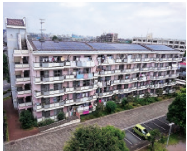
写真3-13-1 屋根貸しによる太陽光発電事業(県営住宅)
