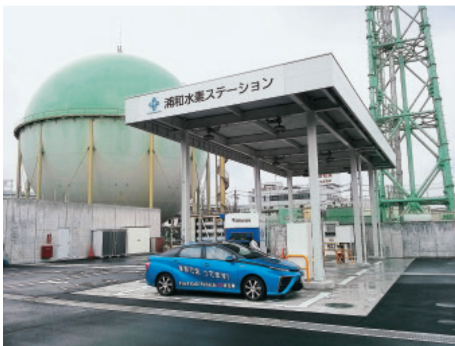
写真3-13-6 水素ステーション（さいたま市）と燃料電池自動車
