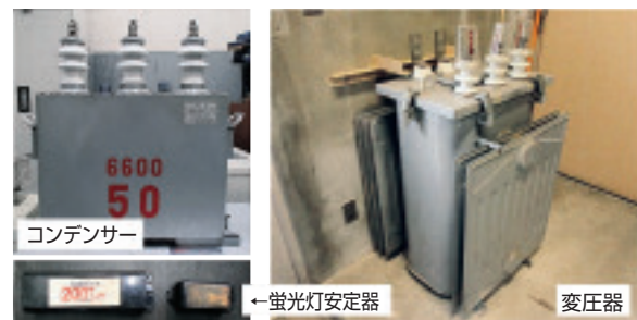
写真1-6-2 高濃度PCB廃棄物(変圧器、コンデンサー及び蛍光灯安定器)
