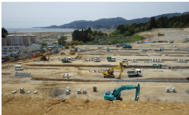
土地区画整理事業に伴う造成工事の様子(陸前高田市高田地区)
