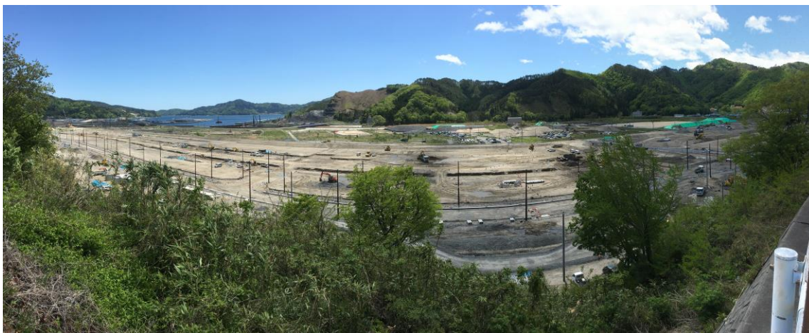
防災集団移転事業に伴う造成工事の様子(大槌町町方地区)
