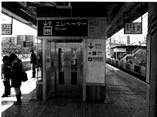
エレベーター (改札内)
