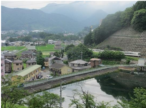
堤体の下流に民家や鉄道が近接するため池（姿の池・横瀬町）
