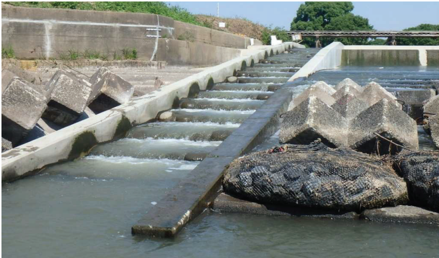
出丸頭首工（川島町） （平成30年9月完成）
