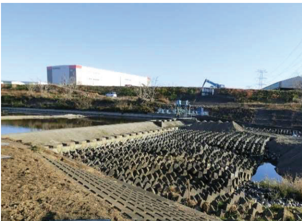
②中山頭首工
