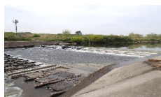
② 菅間頭首工
