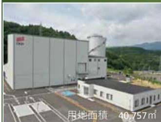
当プラントは、食品ごみ、紙ごみ等の廃棄物系バイオマスを活用した国内最大規模(※)の乾式メタン発酵バイオガス発電施設です。(※当社調べ) 湿式メタン発酵では処理の難しい、紙ごみ、木草類、プラスチック混じりの廃棄物も処理が可能です。受け入れた廃棄物は、破碎・選別の工程を経て、発酵槽にて嫌気発酵させます。生成したバイオガスは1600kWのガスエンジンにより発電し、電力会社へ売電します。また、発電で発生した排熱は回収して、発酵槽の加温等に有効利用しています。
