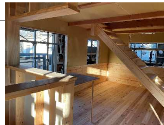
【木造2階建て住宅施工】
