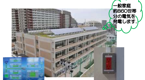
全市立学校に太陽光発電設備と蓄電池を設置
