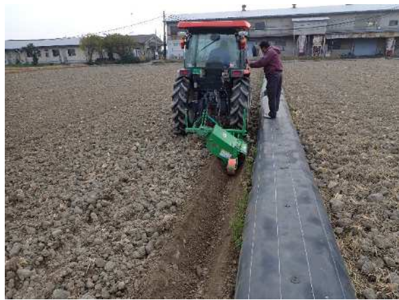
図3-5 明渠の施工
