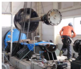
No.① 男沼排水機場地区 ポンプのオーバーホール
