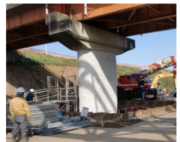
No.⑭ 大里比企北部地区 橋脚の補強
