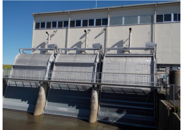
建屋と除塵設備
