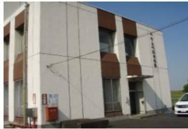
さすなべ排水機場（熊谷市）
