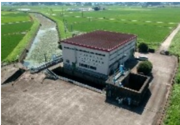
奈良川排水機場（熊谷市）
