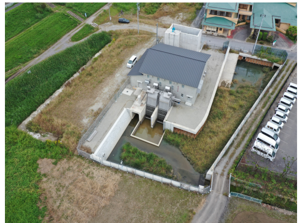
明戸北部排水機場（全景）
