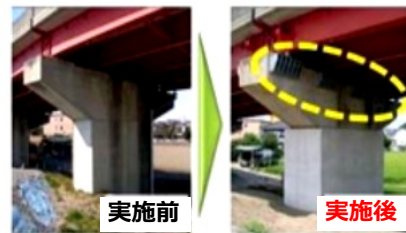
橋桁落下防止のための縁端拡幅による桁かかり長の余裕確保
