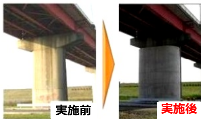
橋脚の変形、倒壊防止のための橋脚コンクリート巻立てによる補強
