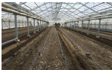
手順1 灌水チューブの設置
