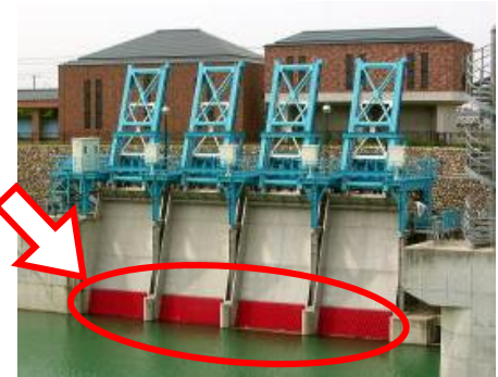
写真2 赤い部分が取水口
