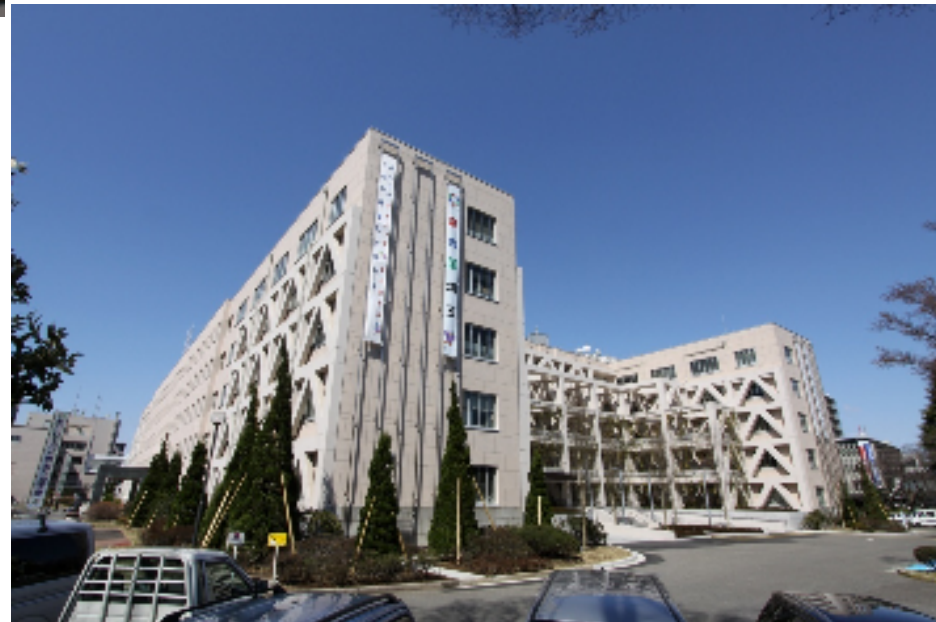
施工後(東側、外部増設架構)
