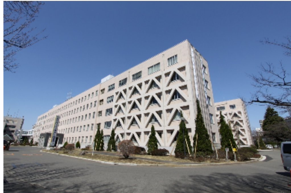
施工後(外部ブレース)
