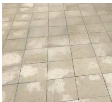
駐車スペースの保水性舗装
