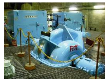
インバータ装置(上)と 送水ポンプ(下)
