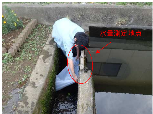
3段目の溜桝から流れ落ちるところで水量の測定を行った
