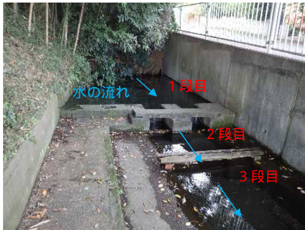
三段あるコンクリートの溜桝を流れる
