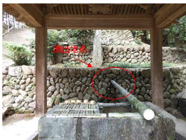
石垣から竹パイプで手水舎に引水している
