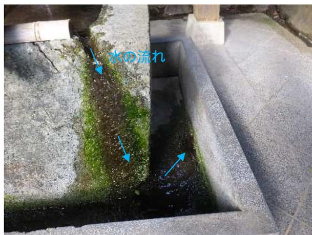
湧水は手水舎から越流し、道路側溝へと流れる
