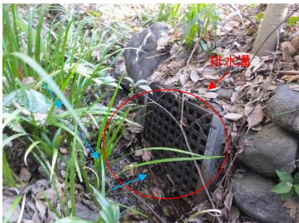
湧水は排水溝から道路側溝へと流れる
