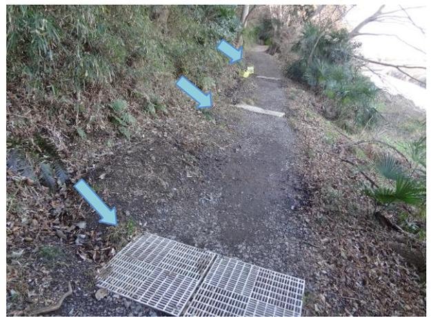
付近の斜面の至る所で水が湧出（湧水の通り道にグレーチングが設置）
