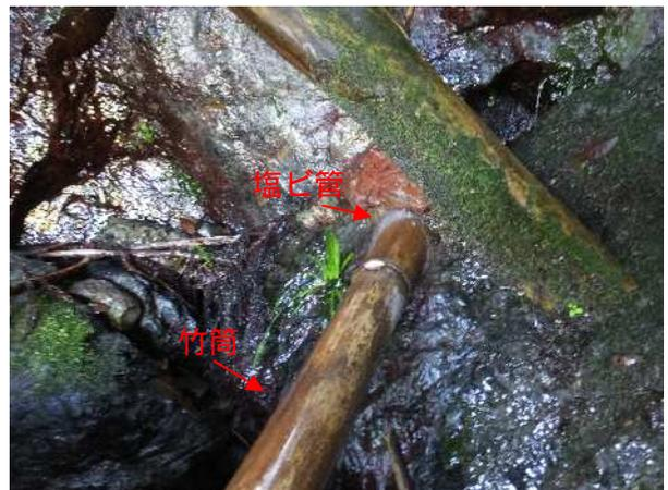
塩ビ管が岩肌に埋め込まれており、その管の間に竹筒が差し込まれている。
