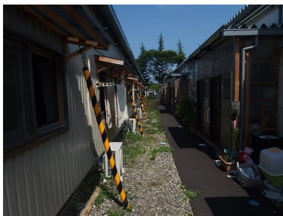
〈仙台市扇町一丁目 仮設住宅〉
