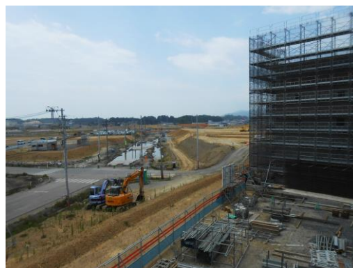
〈南郷地区災害公営住宅周辺の造成工事の様子〉
