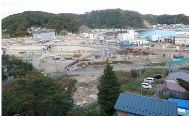
整備が進む宮古港鎌ヶ崎地区
