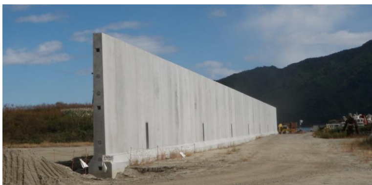
完成した140m区間
