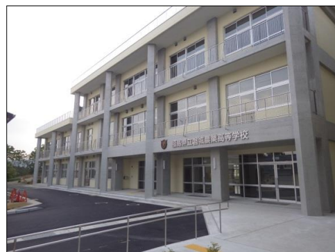
②地震被害のあった農業系高校校舎棟(改築H27.5 竣工)(いわき市)
