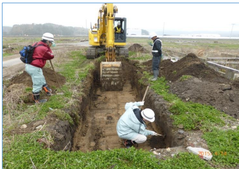
南相馬市小高区の海岸防災林事業地での試掘調査
