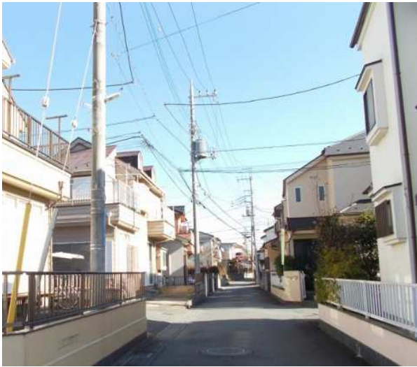
【 防犯灯設置例 】
