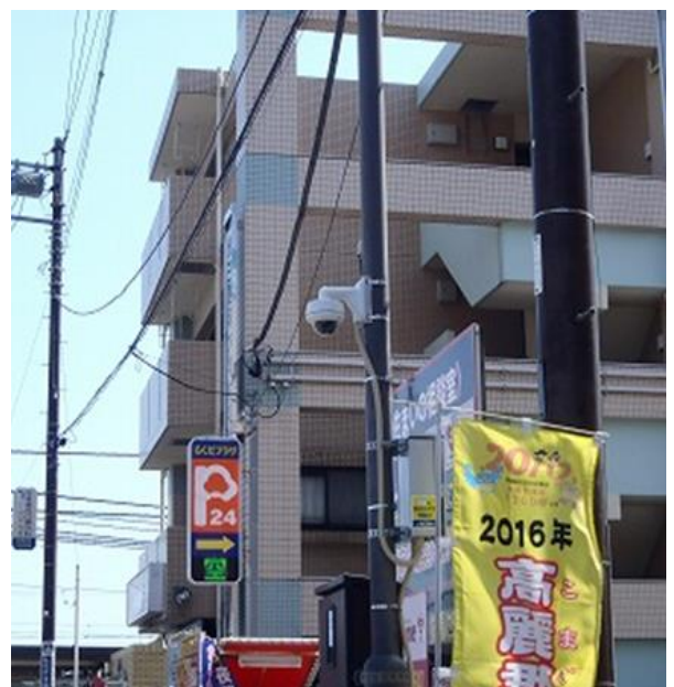
【防犯カメラ設置状況】
