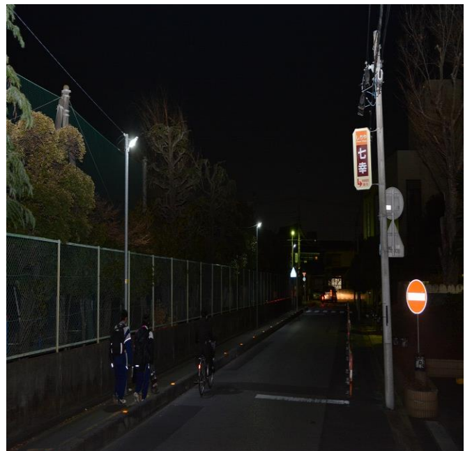
【 LED防犯灯設置道路 】
