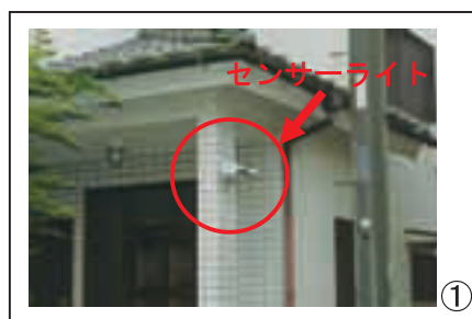
①センサーライトの設置状況
