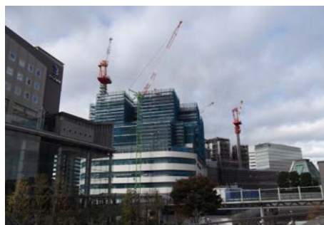
埼玉県立小児医療センター新病院で施工中。
