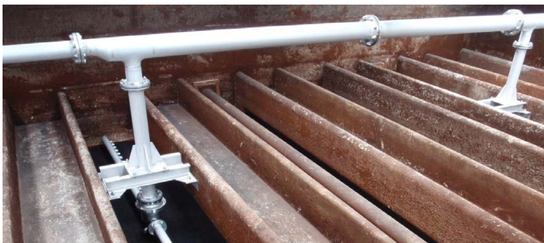
現場施工状況
