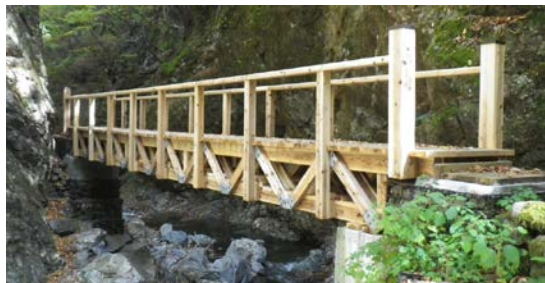
木製トラス橋
