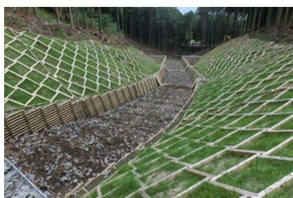
※鉄芯木製法枠工
