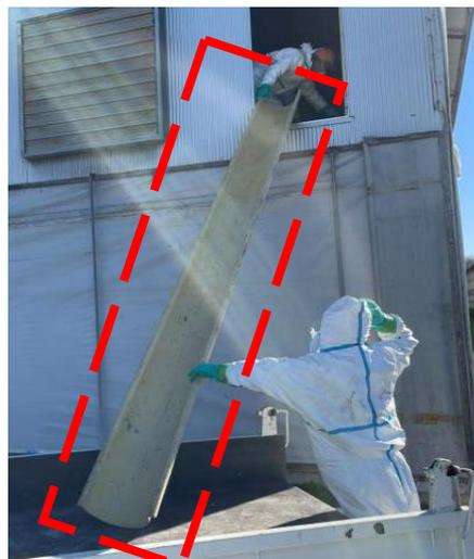
図 7: コンクリートシューターによる高所部からの搬出
