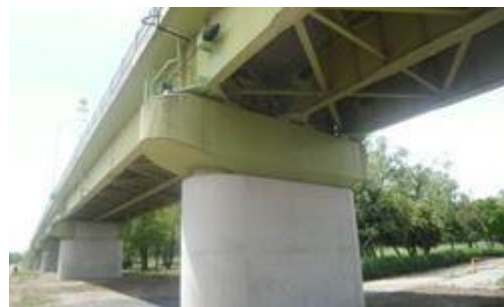
耐震補強を行った農道橋（市野川大橋 吉見町 川島町）
