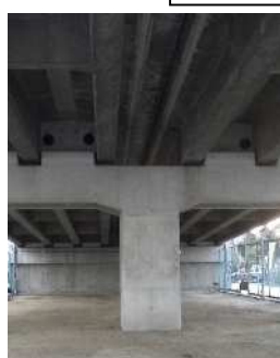
橋脚補強（鉄筋コンクリート巻立て）の例
