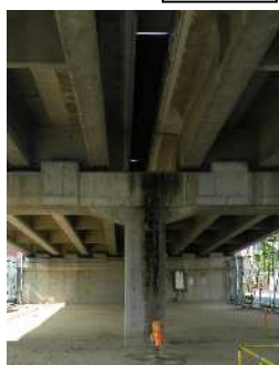
橋脚補強（鉄筋コンクリート巻立て）の例
