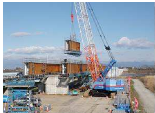
県道伊勢崎深谷線（上武大橋）
