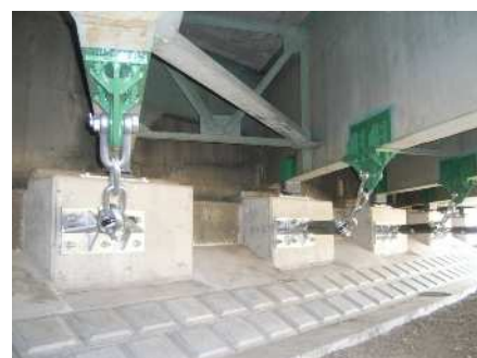
落橋防止装置（チェーン）の例
