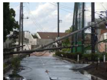
道路閉塞の状況
