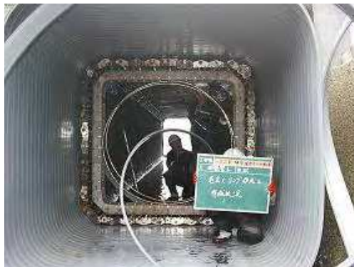
管更生による管渠の耐震化
