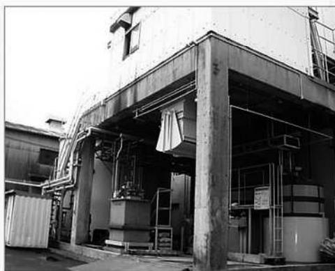
廃水処理設備
