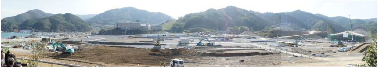
図 1.1.2-5 宮城県女川町の復興状況(地盤の嵩上げ等による現位置復興)
