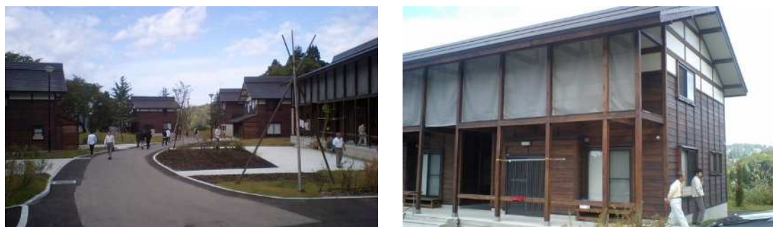
図 1.1.2-4 竹沢地区公営住宅の様子
