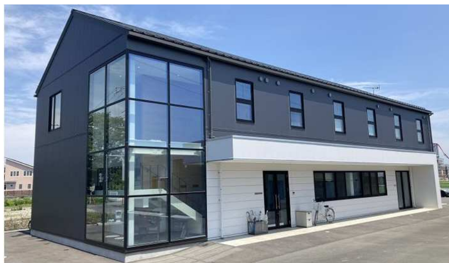
玉井試験場（事務棟）
