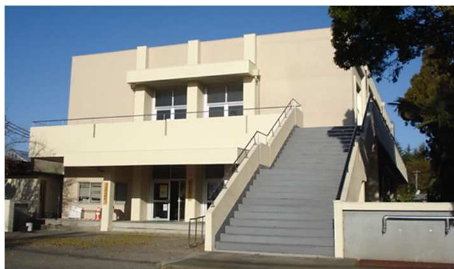
久喜試験場（事務棟）
