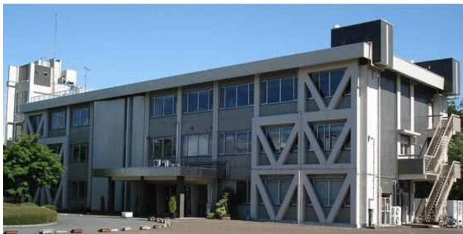
農業技術研究センター本所（本館）
