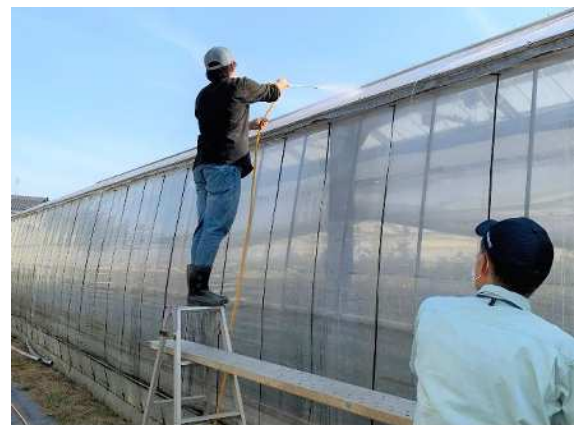
花植木品質改善技術の実証（遮熱資材の塗布作業）
